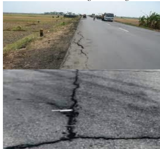
Gambar 7. Edge Cracking
